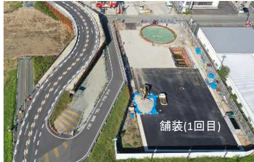
場内舗装（1回目）完了 【発進基地】
