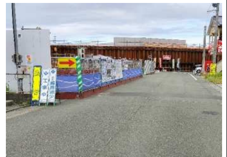
仮囲いフェンス 【発進基地】
