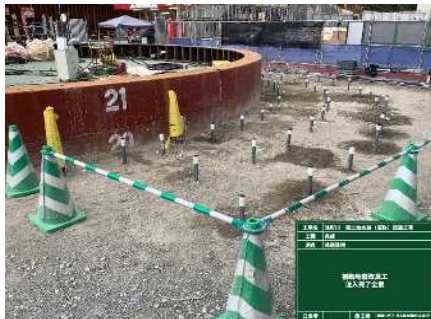
シールド発進部 地盤改良完了 【発進基地】
